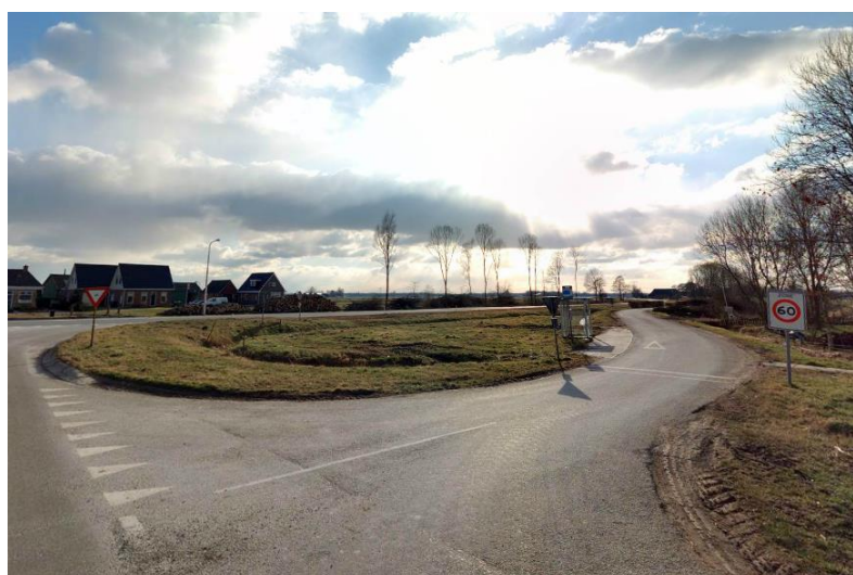
Figuur 45 Aansluiting N351
