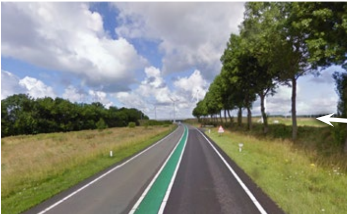
▲ N254, Bernhardweg west. De weg heeft een doorstroombaan en is ingericht als autoweg (maximum snelheid 100 km/uur). Dit wegdeel scoort 1 ster. De score is met name te wijten aan de beperkte rijrichtingscheiding in combinatie met een hoge maximumsnelheid en bomen binnen een zone van 5 meter van de rijbaan. De weg heeft een dubbele asstreek met ribbelmarkering als rijrichtingscheiding, die weggebruikers waarschuwt als ze uit hun rijstrook dreigen te raken. Dit vermindert de kans op een frontale botsing.
