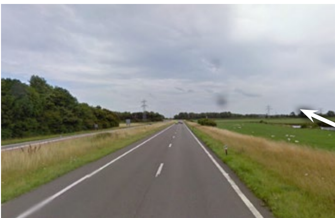
▲ N254, Middelsburgse Schoeweg. De weg heeft een doorstroombaan en is ingericht als autoweg (maximum snelheid 100 km/uur). Dit wegdeel scoort 3 sterren. De factoren die de veiligheid positief beïnvloeden zijn: de fysieke rijbaanscheiding met middenberm (breder dan 5 meter) en de berm zonder obstakels. Verder zijn er weinig kruispunten of invoegstroken. De factor die de score negatief beïnvloedt is het ontbreken van een redresseerstrook aan de rechterzijde.
