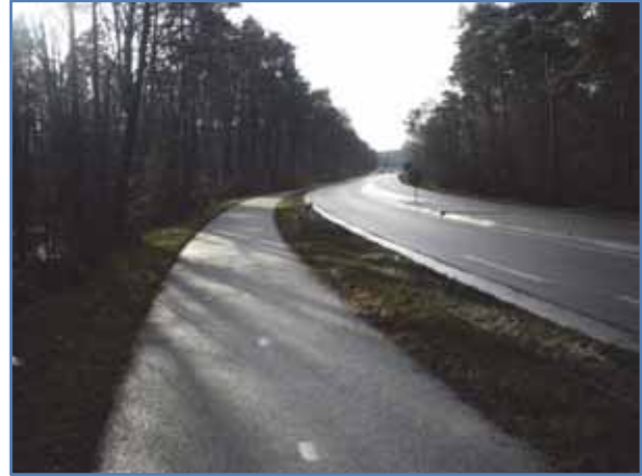
N302 Leuvenumseweg scheiding fiets – rijbaan minimaal. "Varkensruggen markeren".
