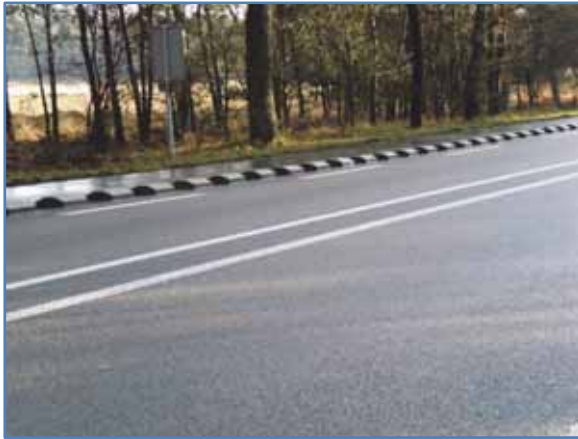
N302 Leuvenumseweg scheiding fiets – rijbaan minimaal. "Varkensruggen markeren".
