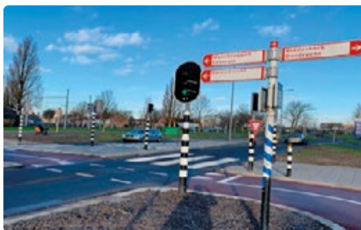
Buitendijktunnel - Colosseumweg. Verbeterde oversteekbaarheid fietsers en voetgangers
