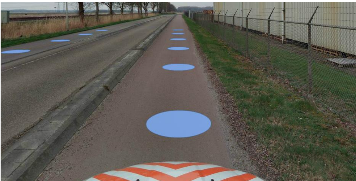
Figuur 20: het fietspad langs de Energieweg, straatbeeld van deeltraject 2.
