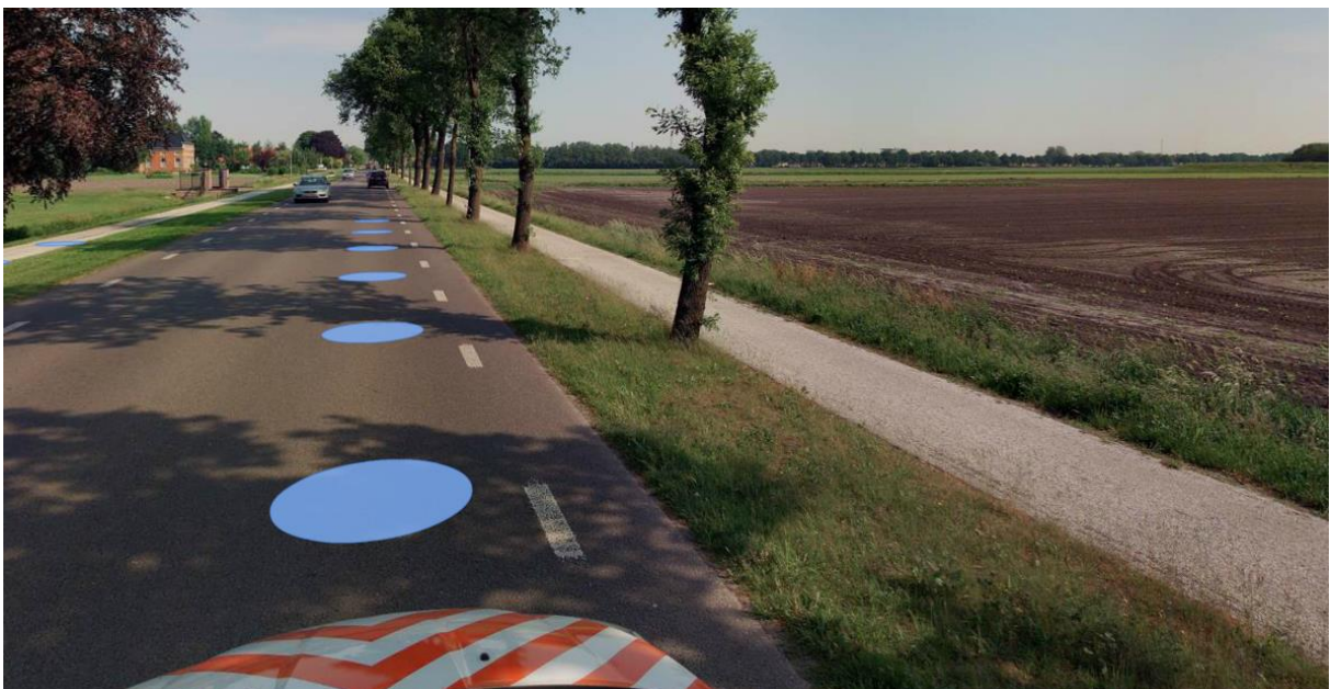
Figuur 52: het vrijliggende fietspad naast de weg Zuiderveen.
