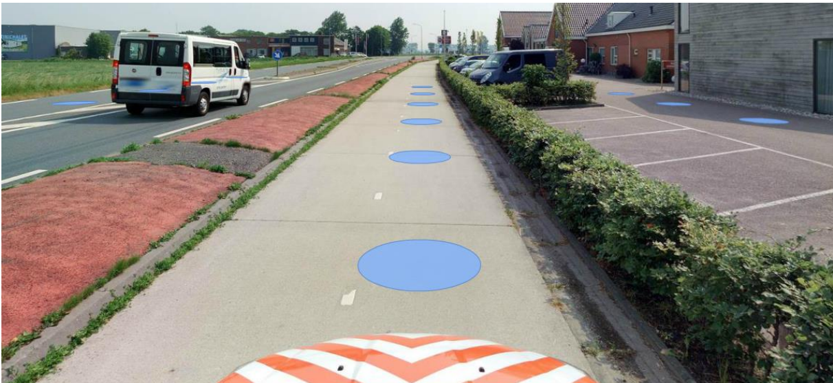
Figuur 7: het fietspad ter hoogte van hotel/rest. Aduard.
